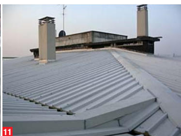
11-12. Applicazione nuovo manto di copertura con pannelli in alluminio coibentati.
