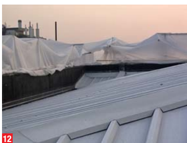
11-12. Applicazione nuovo manto di copertura con pannelli in alluminio coibentati.
