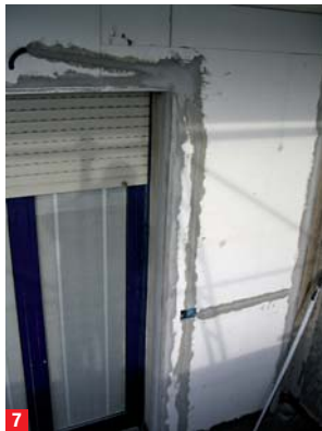
7. Applicazione pannelli in polistirene del termocappotto sulle superfici verticali di facciata.
