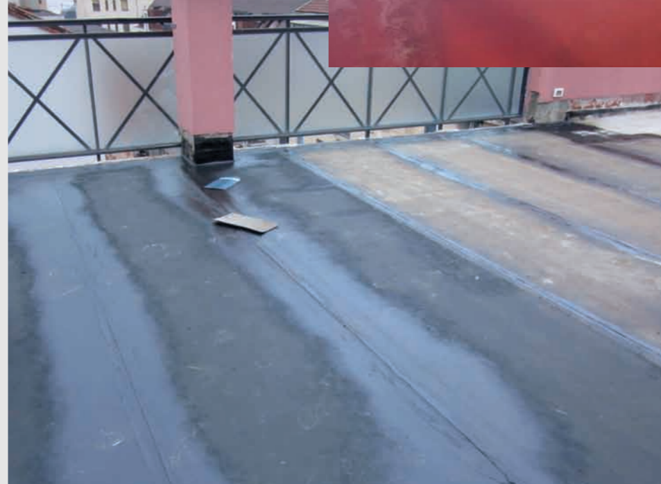
CONDOMINIO Via Paruta, 39 MILANO Lavori di rifacimento terrazzo con nuova impermeabilizzazione e nuova pavimentazione in piastrelle
