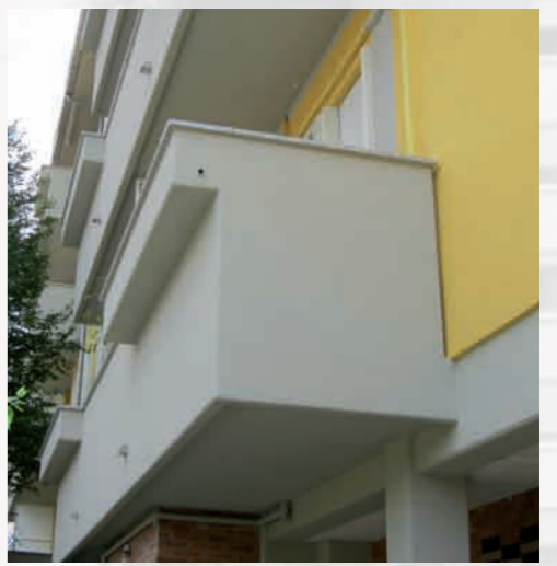
CONDOMINIO Via Ariosto, 3 NOVATE MILANESE Lavori di risanamento cementi armati, balconi e finitura con rivestimento plastico
