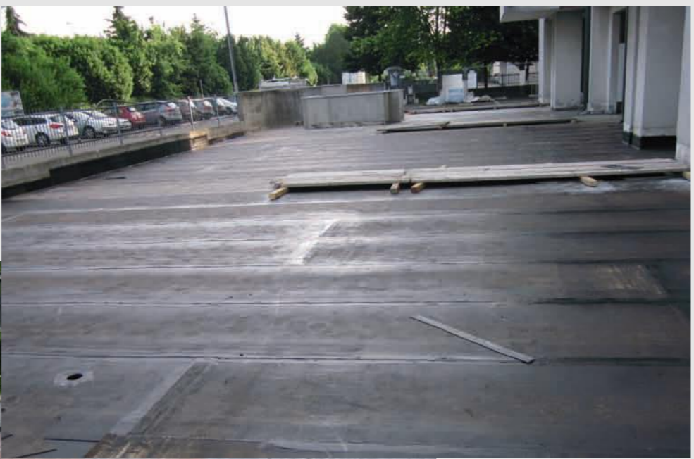
CONDOMINIO Via Teodolinda, 7 SEGRATE Lavori di rifacimento cortile con nuova pavimentazione in autobloccanti
