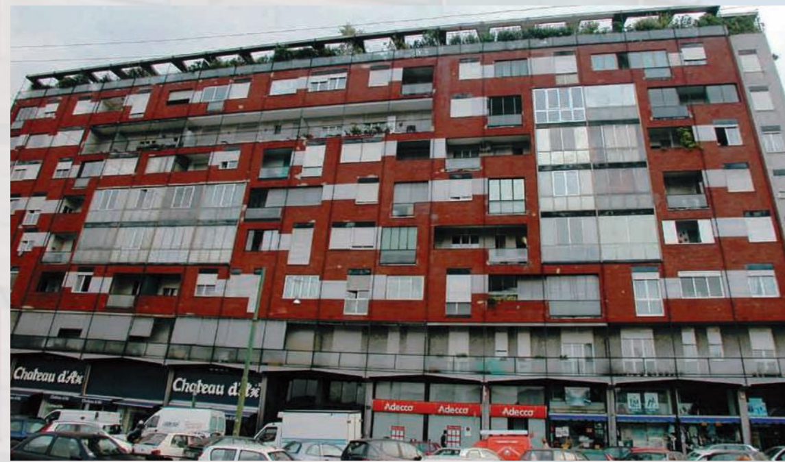
CONDOMINIO Corso Lodi, 47 MILANO Lavori di risanamento facciate, balconi e posa di piastrelle in facciata
