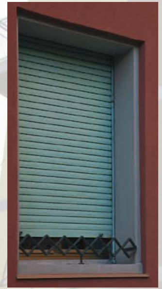
CONDOMINIO Viale Jenner, 63 MILANO Lavori di risanamento facciate e posa di rivestimento termo cappotto
