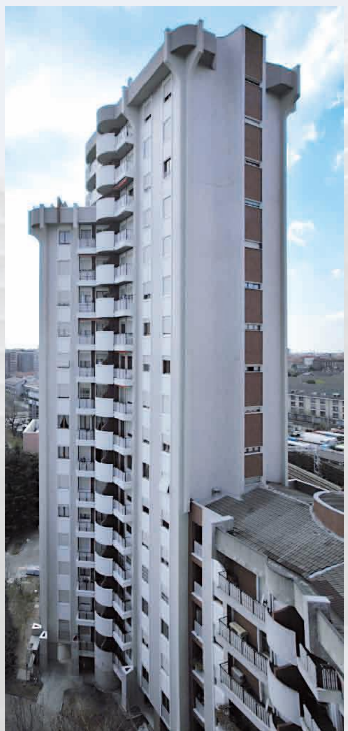
CONDOMINIO Via E. de Marchi, 19 MILANO Lavori di risanamento cementi armati, porzioni in klinker, balconi e finitura con graniglia
