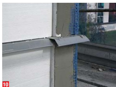
7. Applicazione pannelli in polistirene del termocappotto sulle superfici verticali di facciata.
